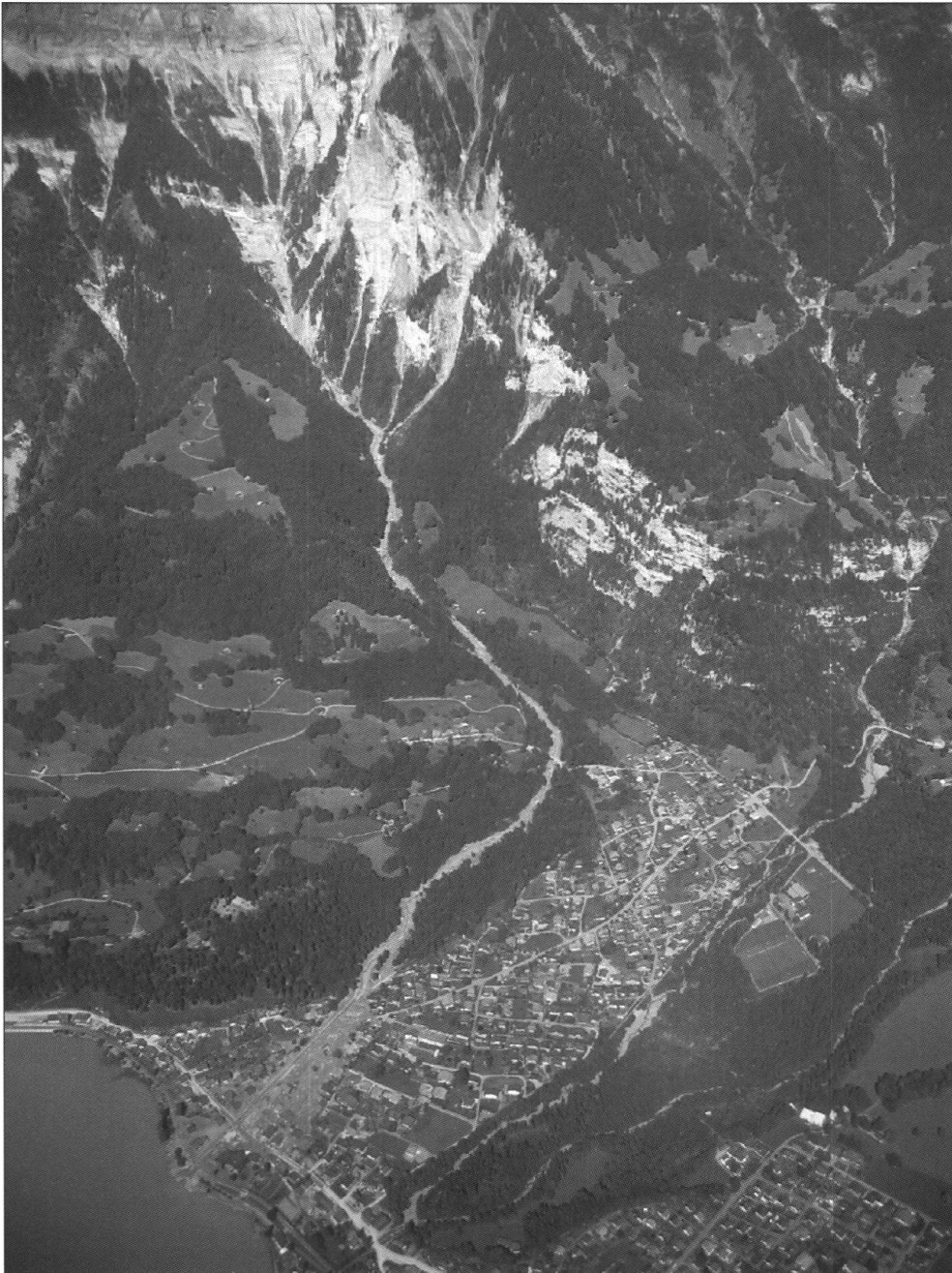
Fig. 1: Glyssibach: Einzugsgebiet und Ablagerungen des Murgangs vom 23. August 2005 auf dem Gemeindegebiet von Brienz. Unterhalb der Rechtskurve des Baches liegt die Siedlung Unterschwenden (Foto: Amt für Wald des Kantons Bern, Abteilung Naturgefahren, Interlaken).
