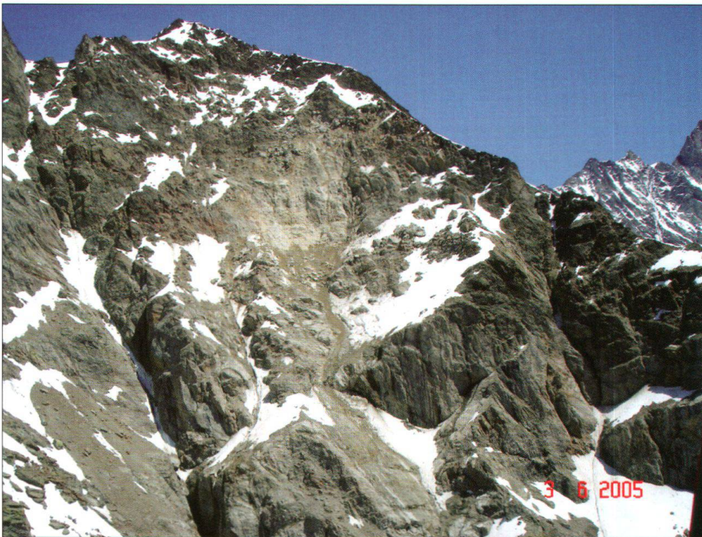
Fig. 3: Seit dem Jahr 2000 auftauender Permafrost am Mettenberg oberhalb Stierregg auf ca. 2'700 m ü. M. Die dadurch ausgelösten Murgänge sind eine Mitursache für die Rutschung Stierregg am 29.5.2005 (660'000 m 3 ), welche das Restaurant zerstörte (Fig. 4).
