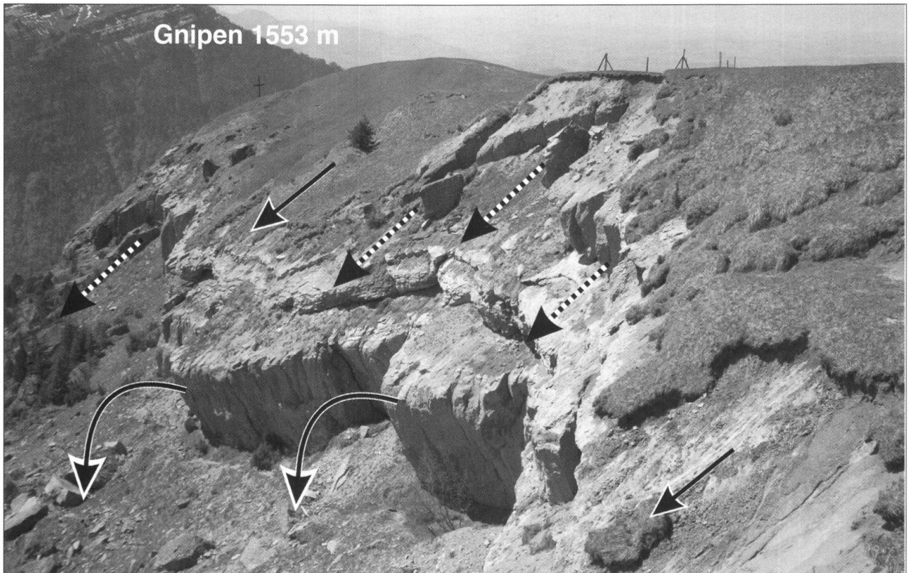
Fig. 13: Darstellung aller risikorelevanten Prozesse im Gratbereich. Geschwungene Pfeile: Toppling (starke Intensität). Gestrichelte Pfeile: Kriechen, Gleiten und Stürzen von Festgestein und einzelnen Blöcken (mittlere Intensität). Ausgezogene Pfeile: Langsames Abgleiten von Oberboden/Lockermaterial auf Mergelschicht (schwache bis mittlere Intensität). Am rechten unteren Bildrand ist dieser Prozess in fortgeschrittenem Stadium zu sehen.
