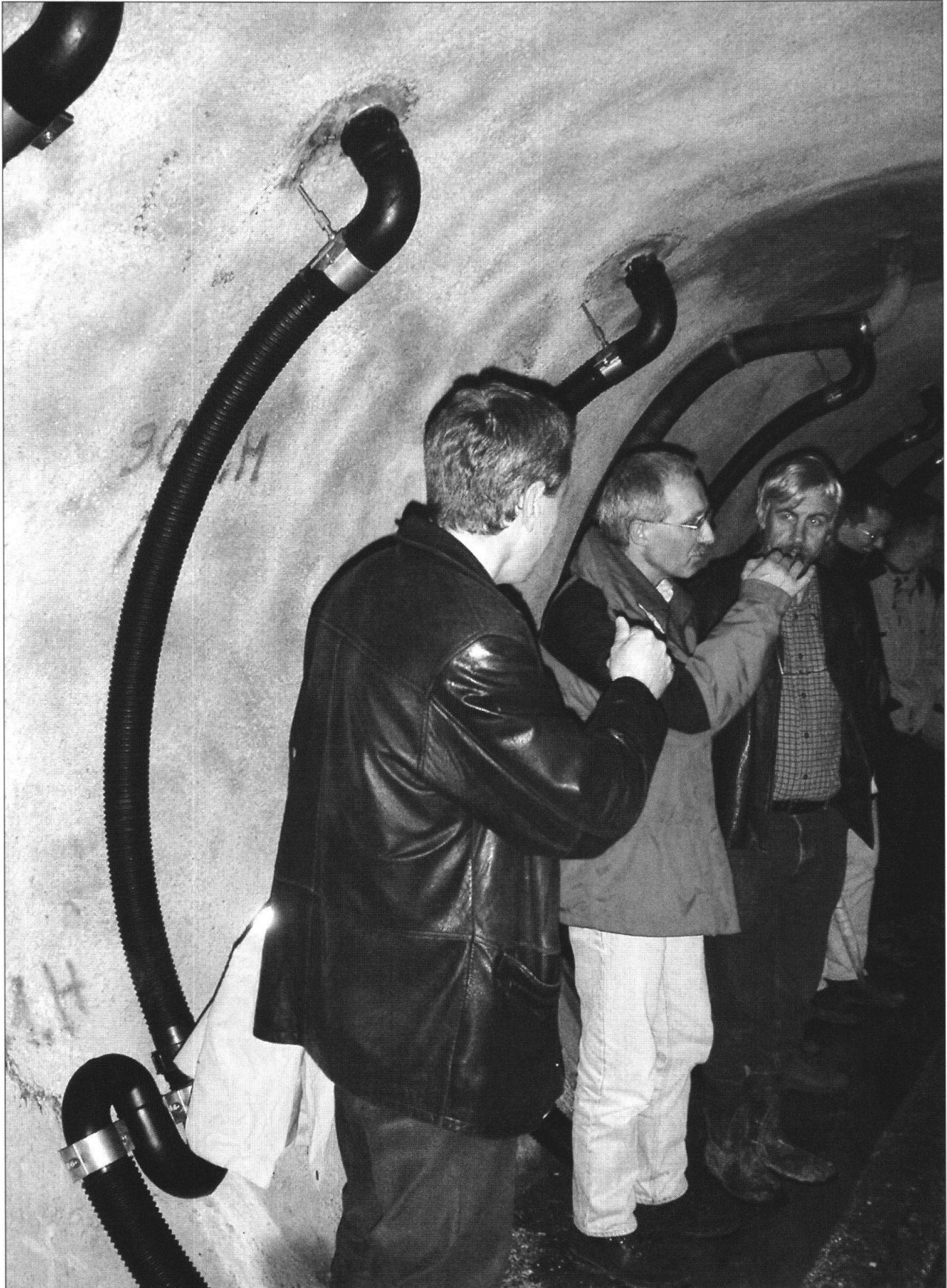
Foto 6: Angeregte Diskussion im Ischenstollen. Gut sichtbar sind die Ableitungen der steil bergwärts angeordneten Drainagebohrungen. (Foto S. Frank)
