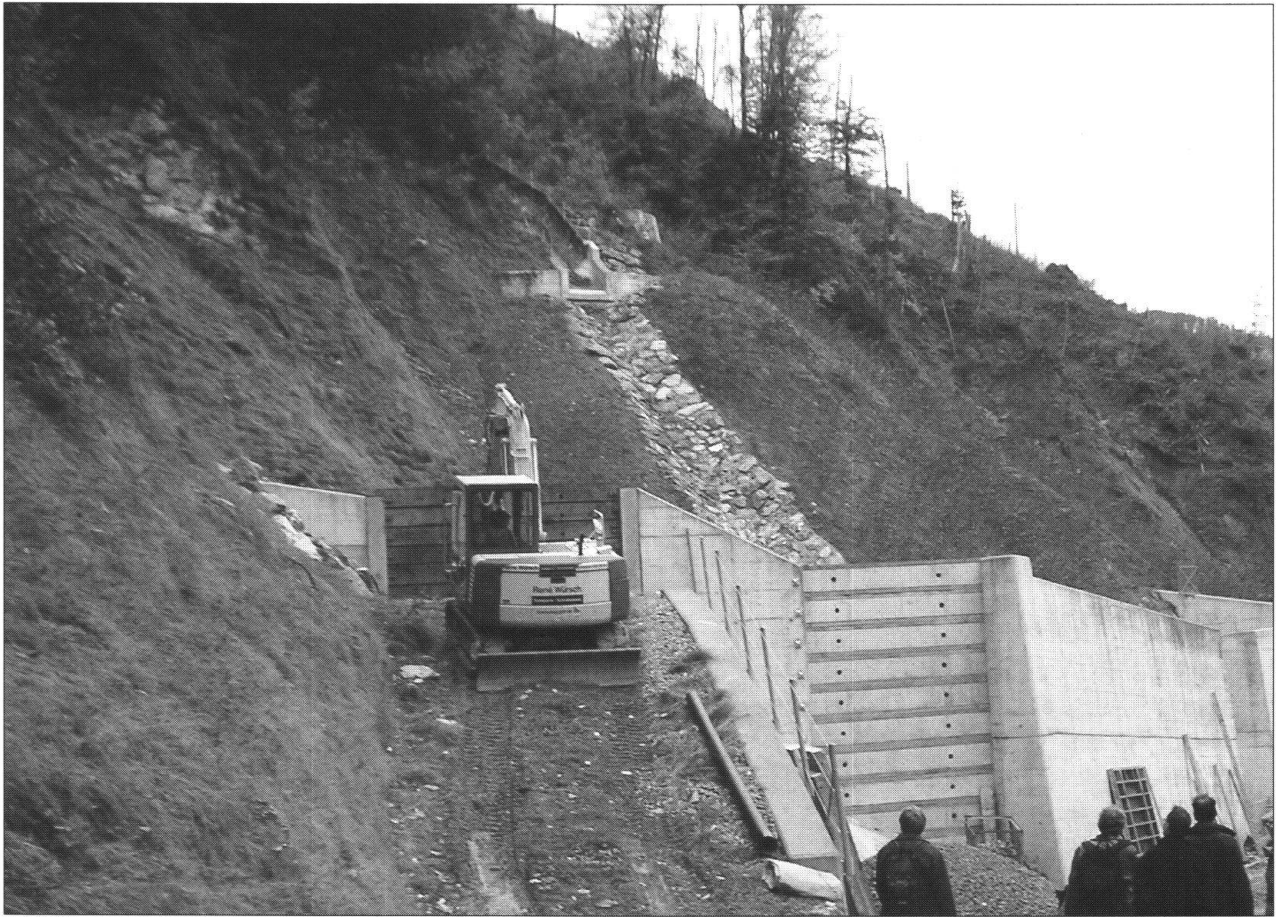
Foto 7: Gerinneverbau und Geschiebesammler in sehr steilem Gelände talseitig der Rutschmasse. (Foto S. Frank)
