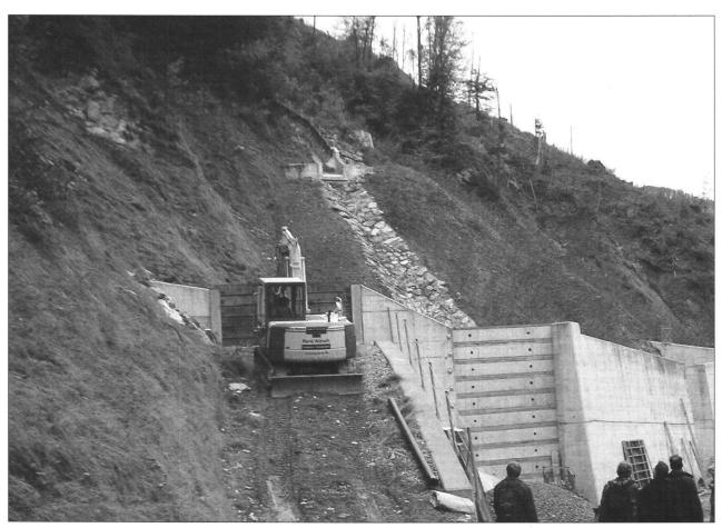
Foto 7: Gerinneverbau und Geschiebesammler in sehr steilem Gelände talseitig der Rutschmasse. (Foto S. Frank)
