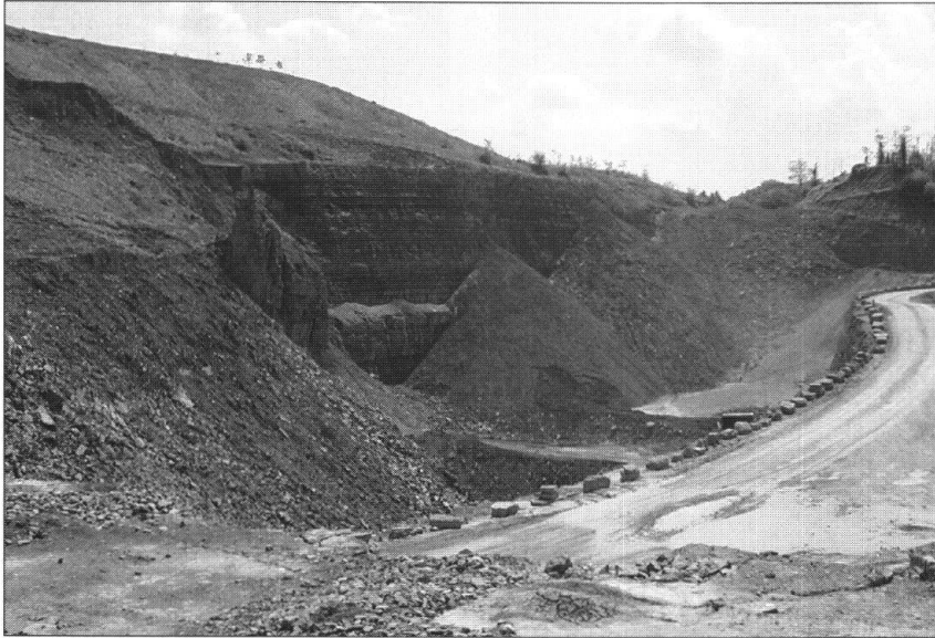
Fig. 2: Blick in das, im Rahmen der Renaturierung aufzufüllende, Abbaufeld. Rechts der instabile Felsriegel, über dessen Krone eine Transportpiste verläuft.
