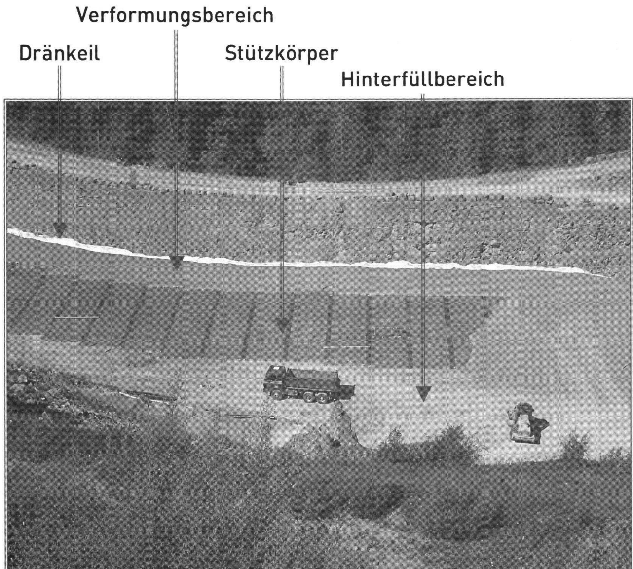
Fig. 4: Das teilweise aufgefüllte Abbaufeld während den Einbauarbeiten.
