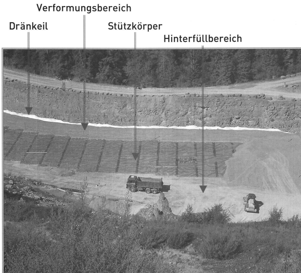
Fig. 4: Das teilweise aufgefüllte Abbaufeld während den Einbauarbeiten.
