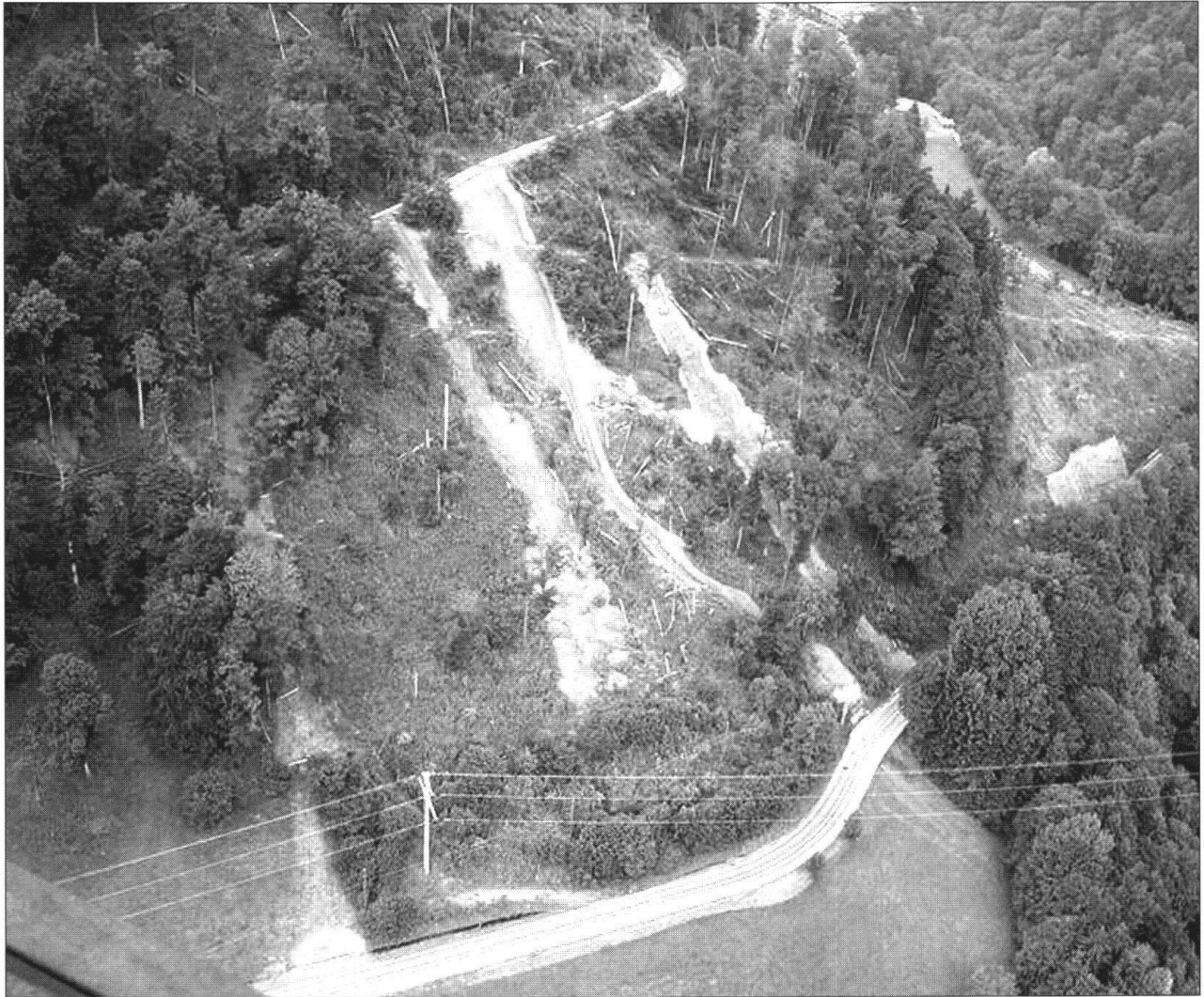
Fig. 6: Flugaufnahme der Muren Nr. 1, 2, 3, und 6 (von rechts W nach links O) vom 25.06.2003. Die Murgangrinnen sind bereits ausgeräumt und mit Kokosmatten befestigt.
