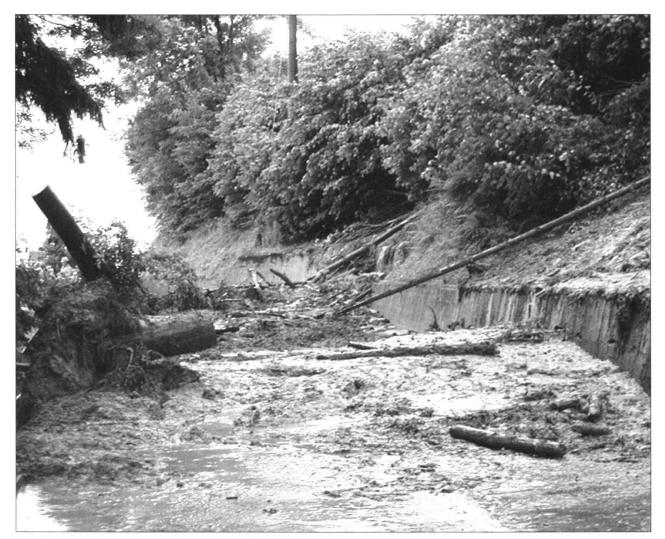
Fig. 1: Dünnflüssige Murgangablagerungen (Mure Nr. 1 im Vordergrund, Mure Nr. 2 im Hintergrund) mit viel Sturmholz auf der viel befahrenen Kantonsstrasse Littau/Malters-Kriens.
