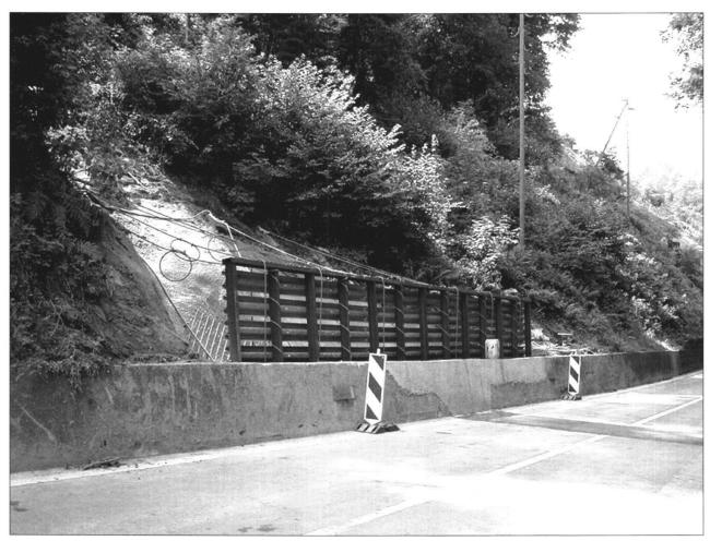
**Fig. 9:** Flexible und permeable Schutzwände aus Stahlprofilen wurden als Schutzmassnahme zwischen Auffangraum und Strasse versetzt. Die etwa 1 m unter das Strassenniveau reichenden Schutzwände – hier bei Murgang Nr. 1 – sind ähnlich einem Steinschlagschutznetz an Stahlseilen rückverankert.
