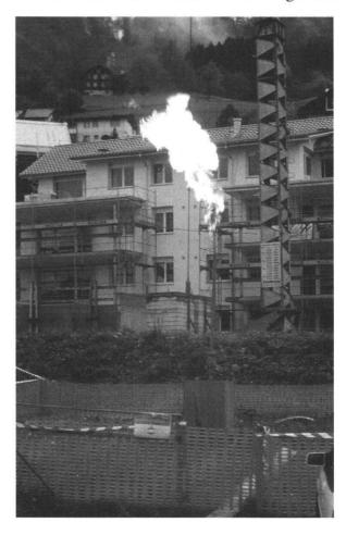
Häuser beeinträchtigt wurden. Der Gasdruck am Bohrlochkopf konnte nun ebenfalls zuverlässig gemessen werden. Er betrug direkt nach dem Umbau, bei gedrosselter Förderung, 2.6 bar. Die bisherigen Installationen der Wehrdienste konnten abgebaut werden und das Sicherheitsdispositiv auf die Abschrankung der Fackelanlage und der Bohrung reduziert werden (Fig. 4).
