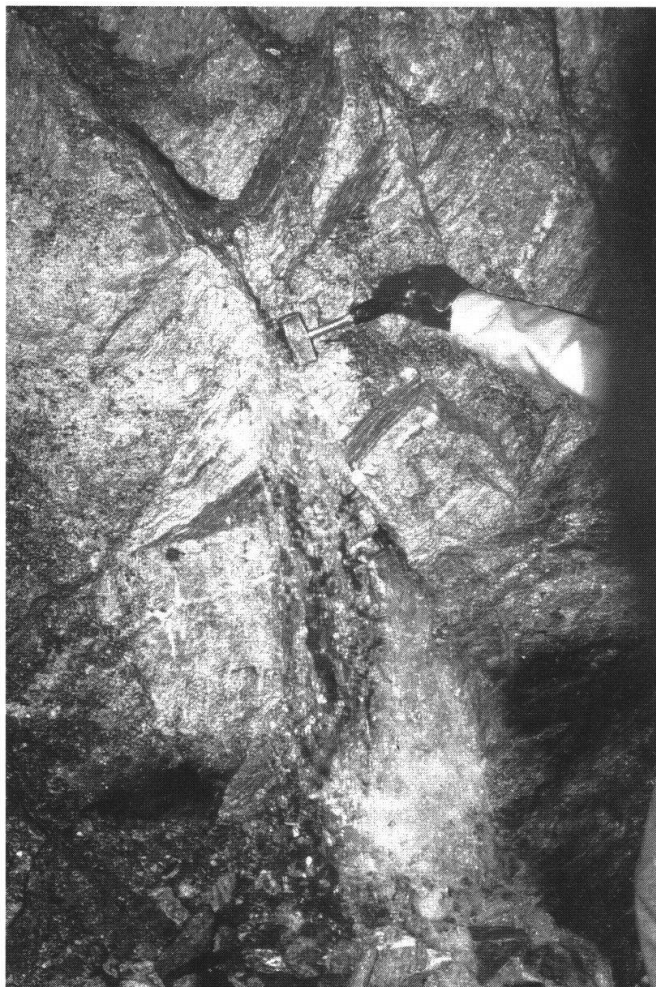
Fig. 6: Wasserführende Kluft im Sondierstollen Silz.
