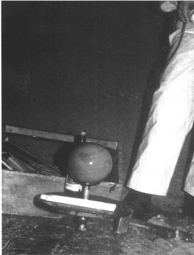
Fig. 3: Kugelventil im Druckstollen (ausgebaut).
