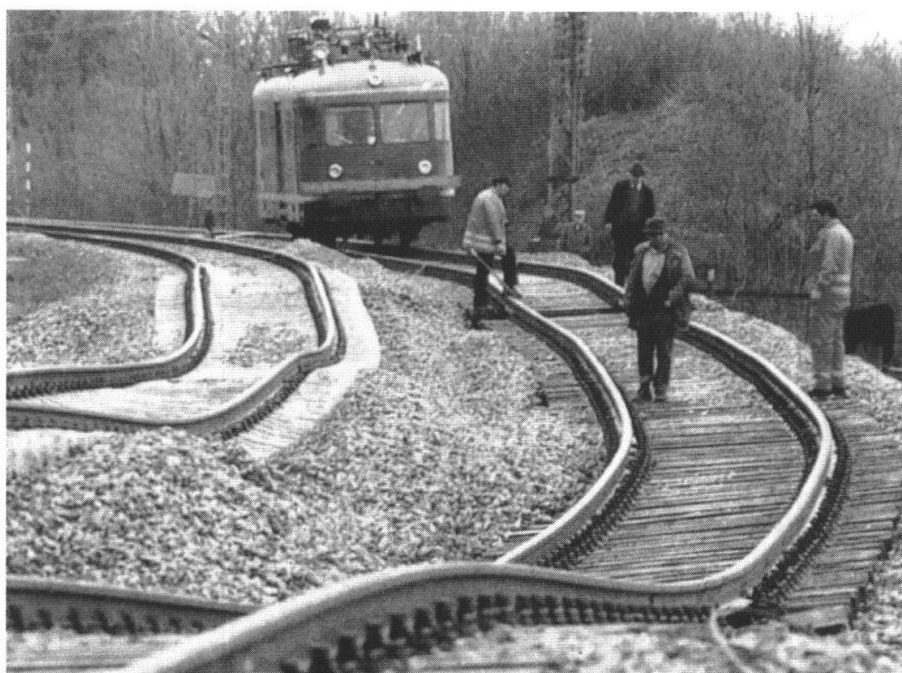
Fig. 2: Hangrutschung am Paderborner Berg, die die Bestandsstrecke schwer beschädigt und nachhaltig gestört hat und jetzt vom Eggetunnel umfahren wird. Situation 1988. (Foto: GLA Nordrhein – Westfalen).
