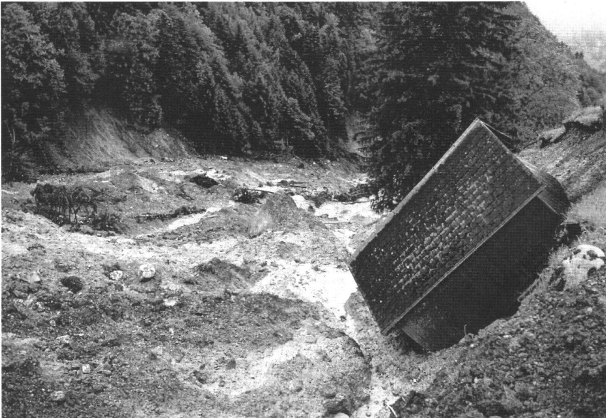
Fig. 4: Zerstörte Alphütte der Alp Flywald (Bild Ch. Hegg).
