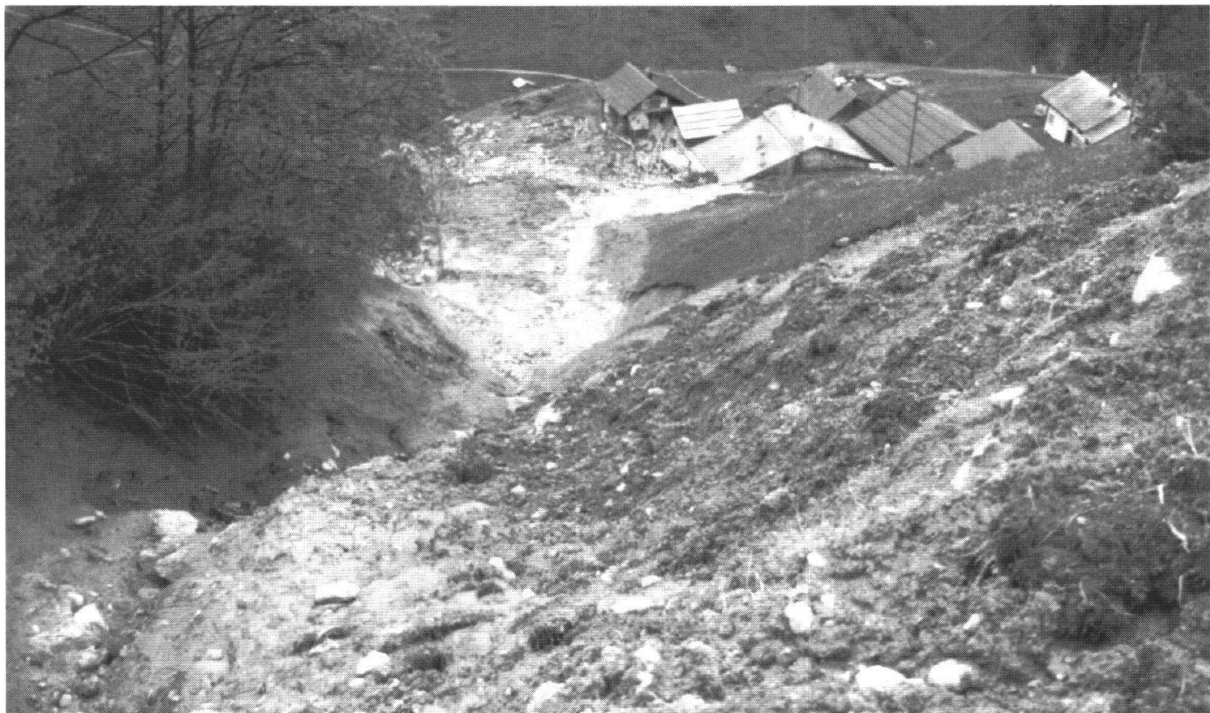
Fig. 2: Übersicht über die Transitstrecke und den Ablagerungsraum der Hangmure am östlichen Rand des Weilers Silblen
