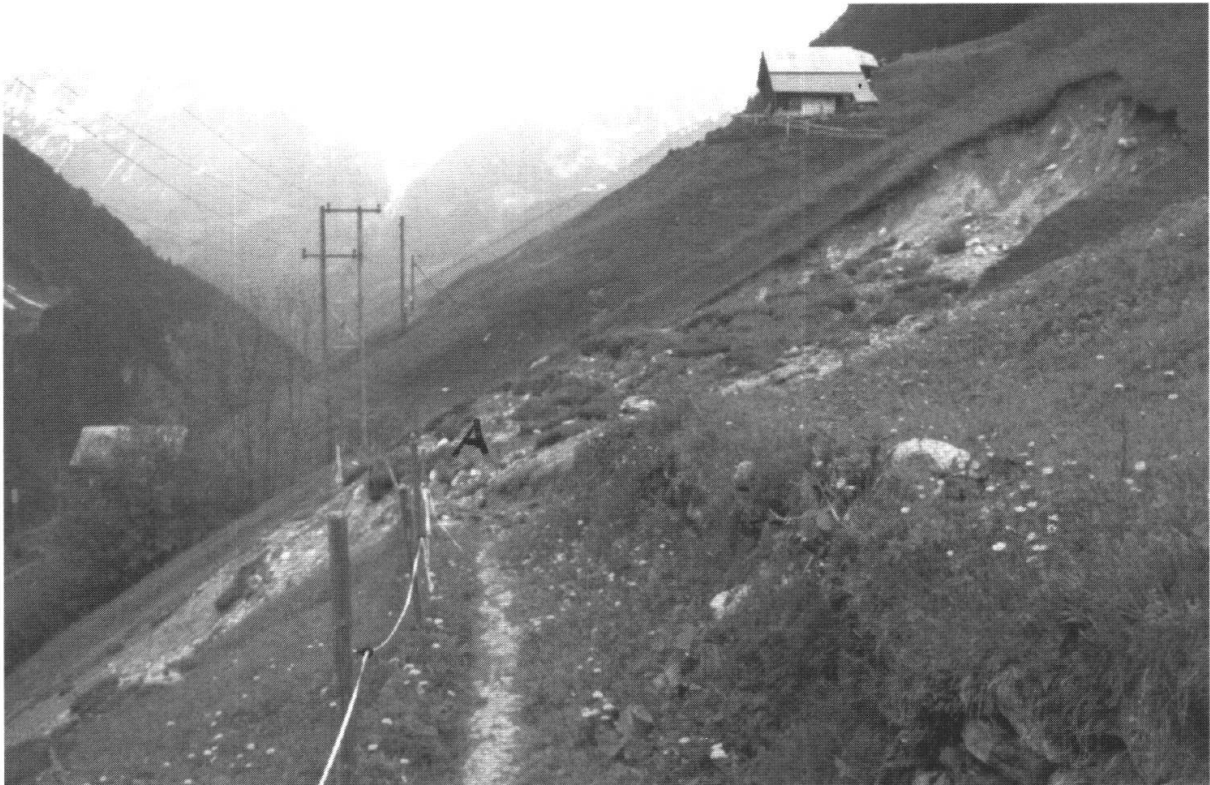
Fig. 1: Anrissnische einer Hangmure oberhalb des Weilers Silblen
