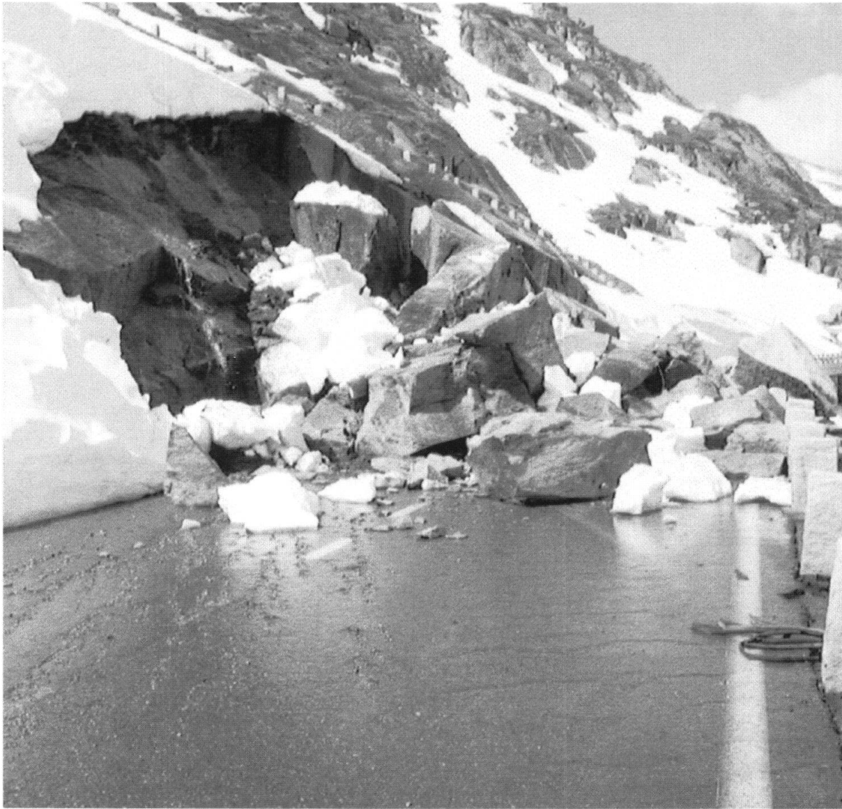
Fig. 12: Abgeglittene Granitplatten an der Grimselpassstrasse.
