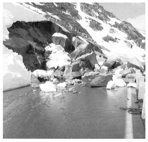
Fig. 12: Abgeglittene Granitplatten an der Grimselpassstrasse.
