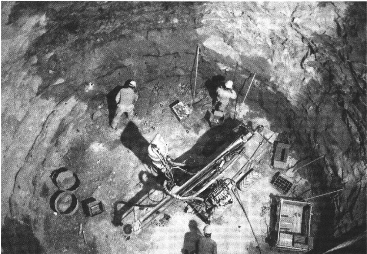
Fig. 3: Bohrungen für den Sprengvortrieb im Schacht Lyren (Aufnahme S. Mützenberg).
