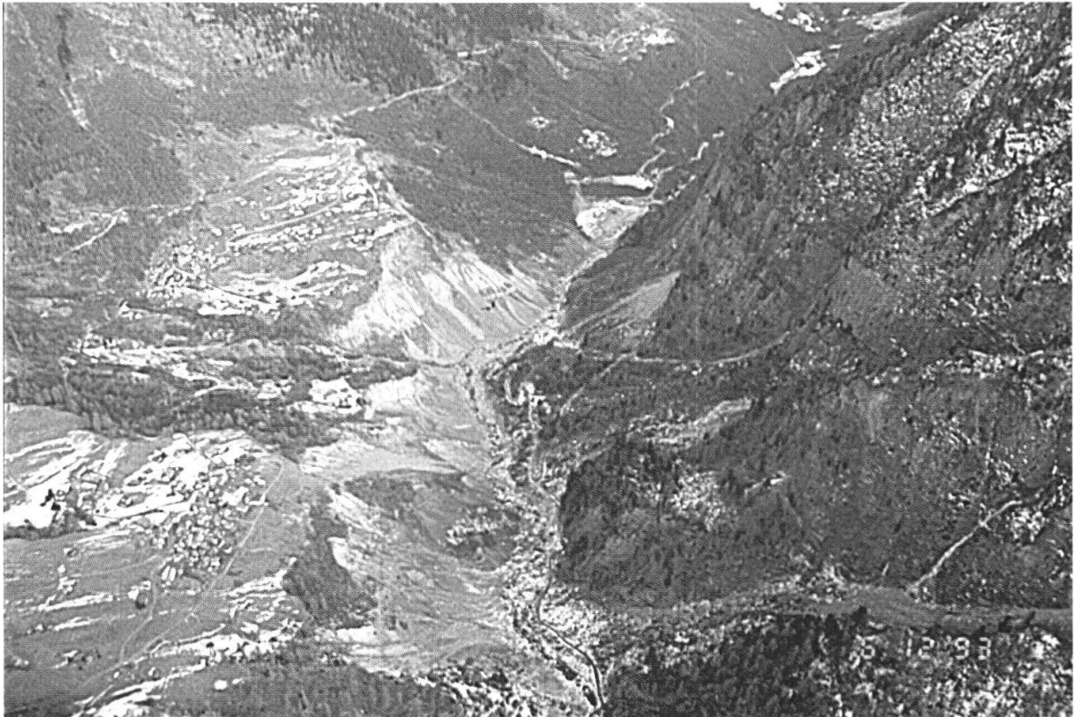
Fig. 1: Veduta aerea dello slittamento di Campo Vallemaggia. Si nota il carattere isoclinale della roccia in posto, e la struttura a zolle della massa in movimento.
