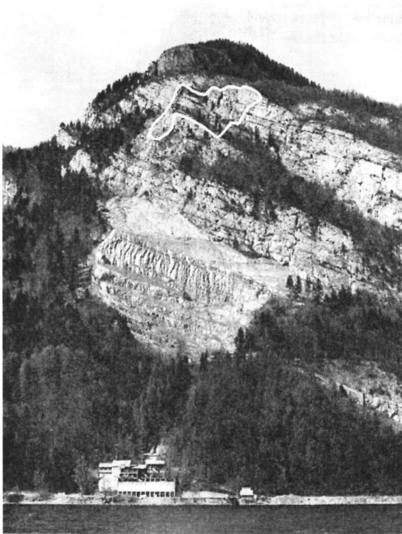
Fig. 1: Schwarzbau bei Amden von Süden: Felswände des Schrattenkalkes mit Um- grenzung der abgestürzten Felspartie.
