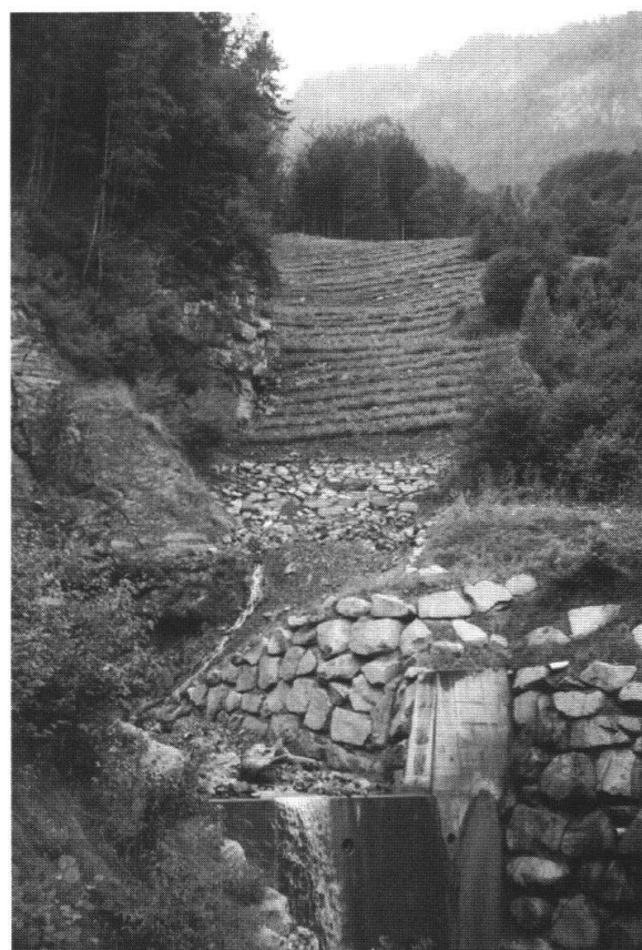
Fig. 4: Das alte Bachbett wird aufgefüllt, Blick von Osten.
