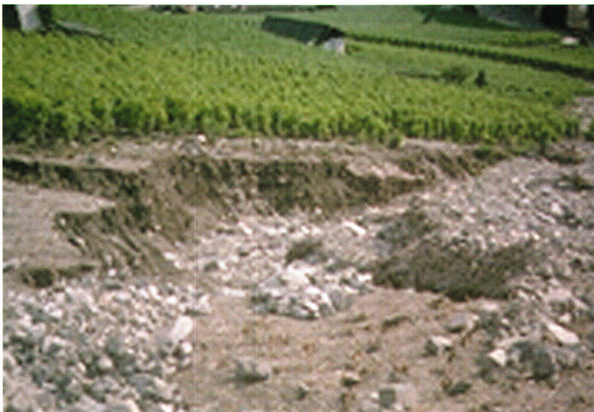
Fig. 3: Surcreusement provoqué par les laves torrentielles dans le cône de déjection
