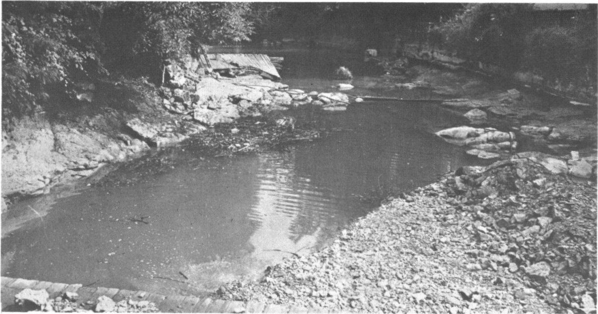
Abb. 1 Uebersicht über die Fundstelle zu Beginn der Bachsanierung. Links- und rechtsufrig die aufgeschlossenen Keuperschichten. Ungefähr in der Mitte des Bildes (oberes Drittel) Reste der unterspülten alten Schwelle. (Photo von K. Hunziker, Kantonsmuseum Baselland).
