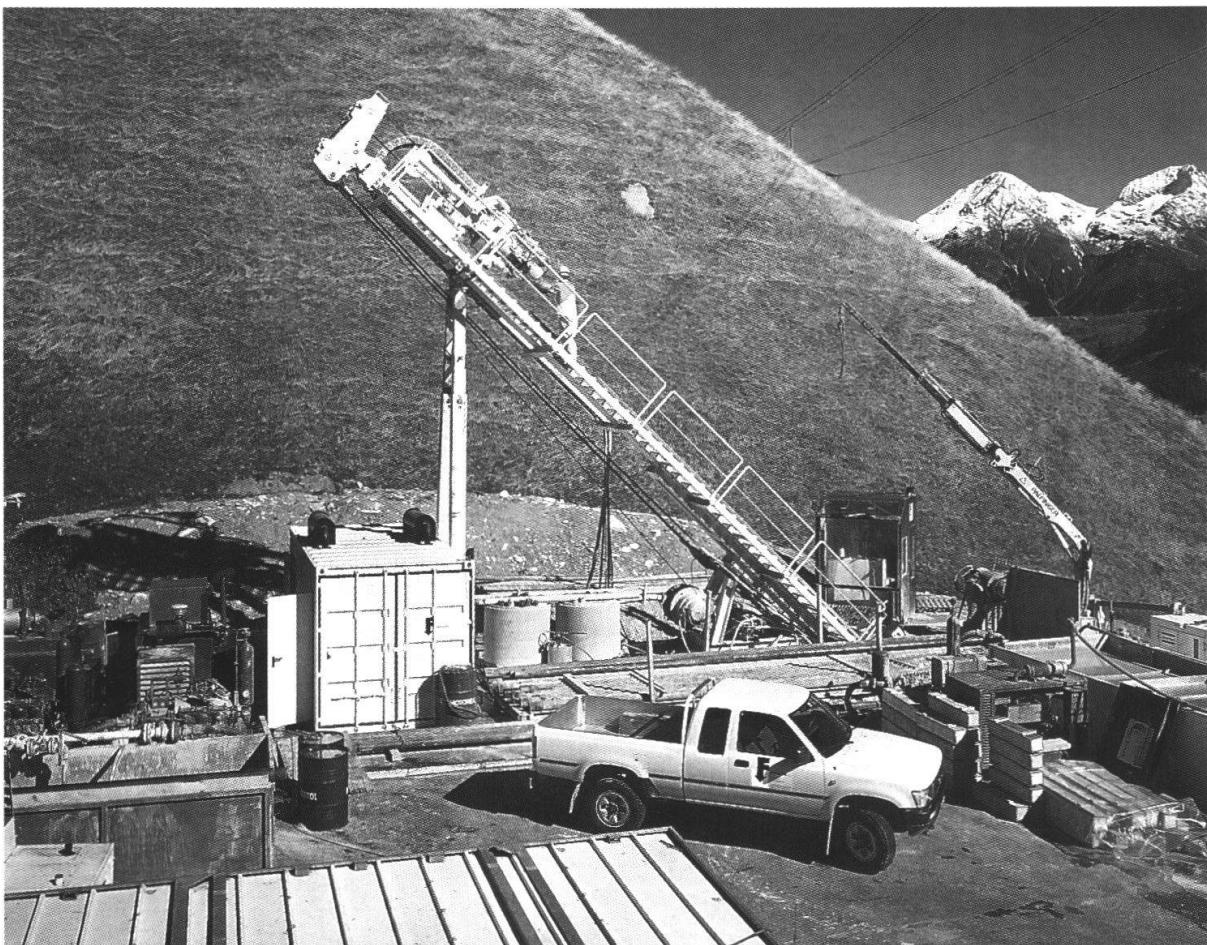
Foto 2: Schrägbohranlage für Sondier- und Zielbohrungen RC-7; 70 to Hakenlast
