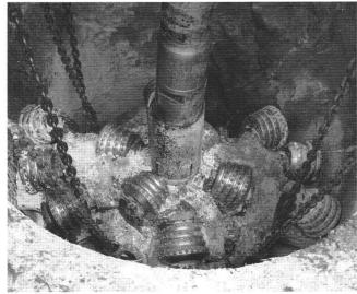
**Foto 6:** Raise-Bohranlage RH-71 im Einsatz für Lüftungsschacht Locarno mit Bohrgestänge Ø 10"
