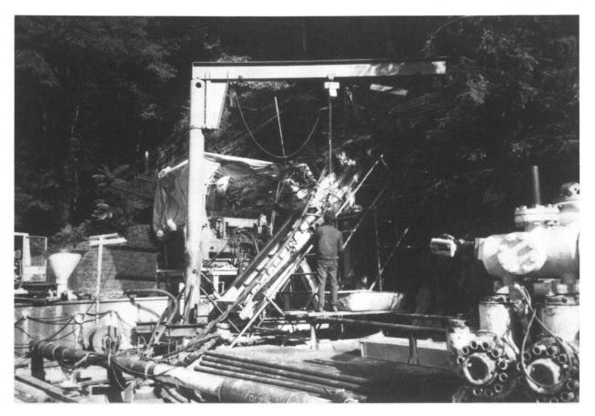
**Foto 5:** Zielgenaue Schrägbohrung 45° aufwärts über 600 m zum Einzug von Kommunikationskabeln (Bodio - Sobrio)
