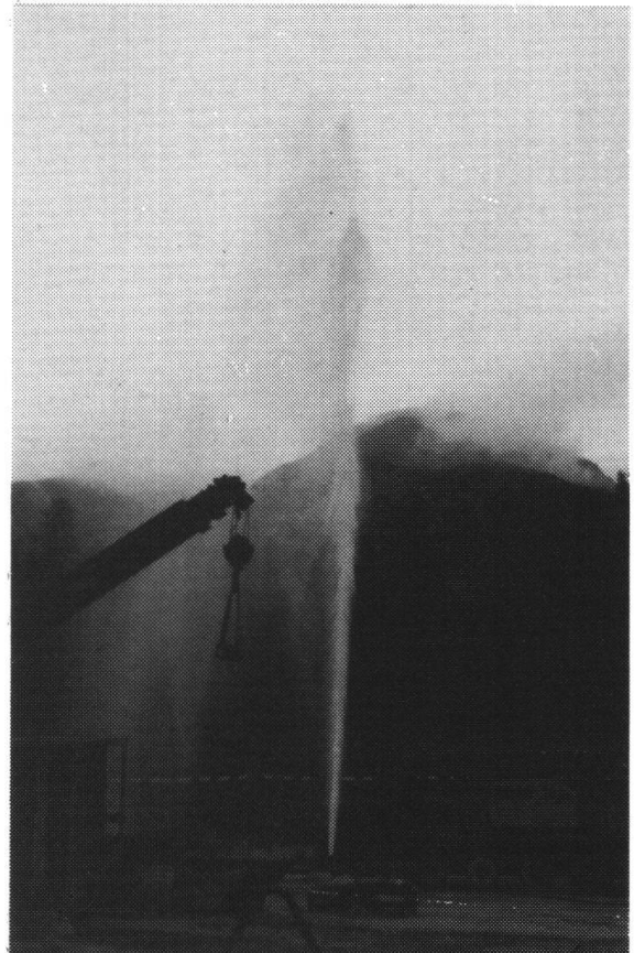
Fig. 2: Wasser/CO 2 -Aufstoss mit gut 20 m hoher Fontäne nach Abschluss der Bohrung, am 14.10.1991
