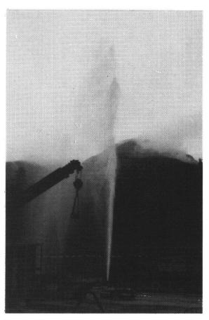
Fig. 2: Wasser/CO<sub>2</sub>-Aufstoss mit gut 20 m hoher Fontäne nach Abschluss der Bohrung, am 14.10.1991
