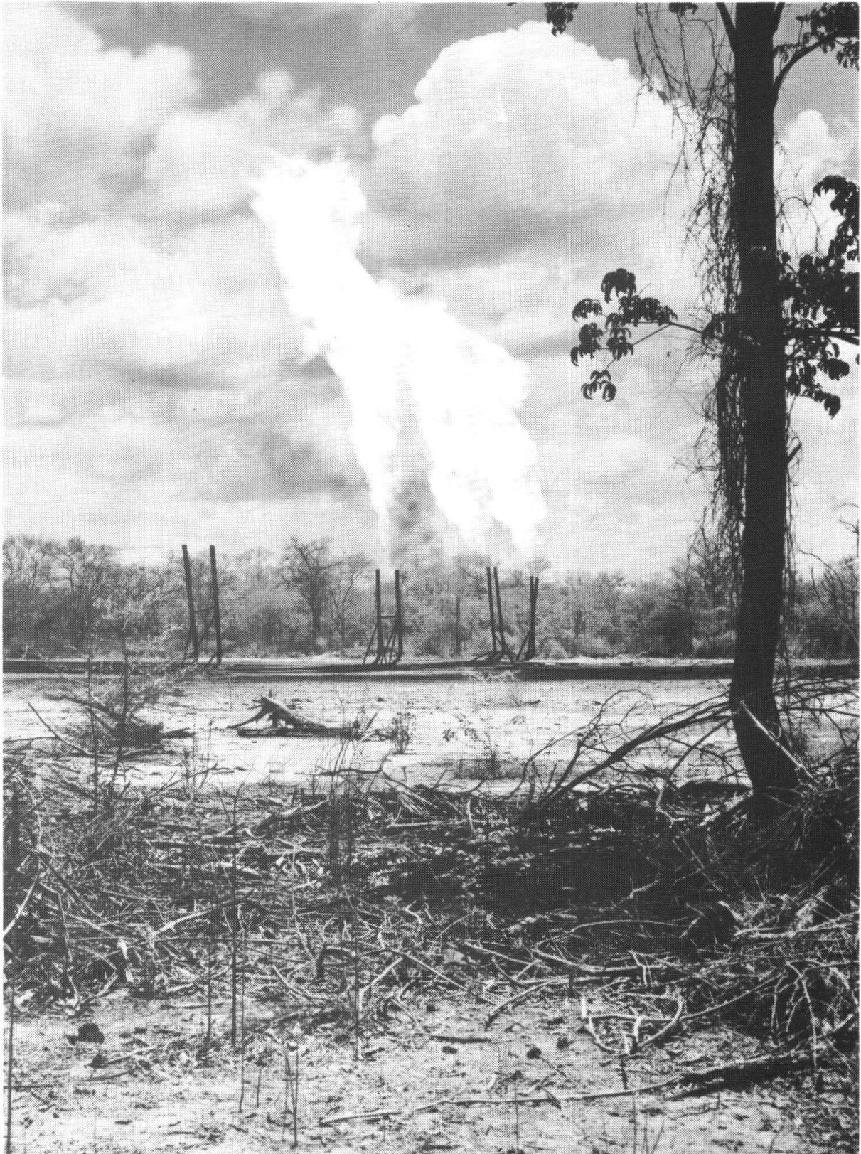
Gasflammen auf dem Oelfeld La Paz, Venezuela, aufgenommen am 9. Mai 1954. Für das viele Gas aus den Oelfeldern hatte man damals keine Verwendung! Es wurde abgefackelt, die Flammen waren 40 - 50 Meter hoch.
