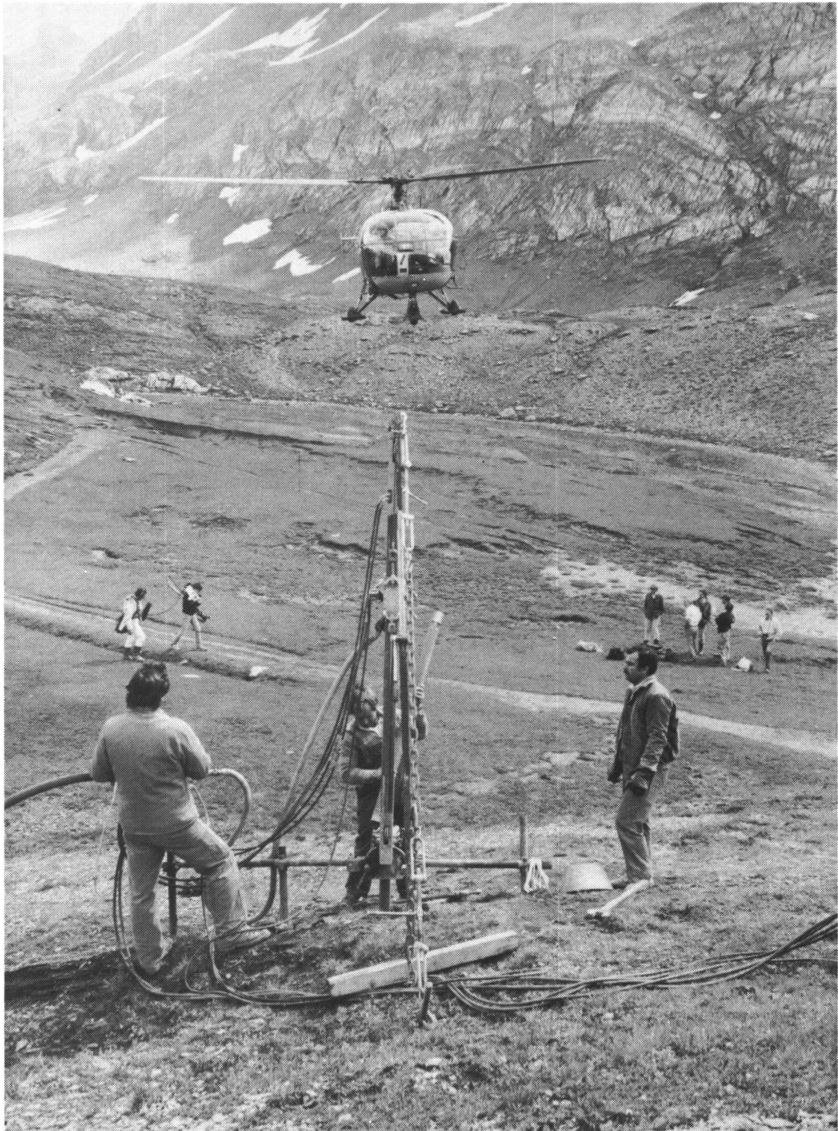
Bild 6 Bohrergerät für Sprengschußseismik auf dem Rawilpass. Zusätzlich zur Vibroseis wurden Sprengschüsse von 30 - 300 kg Dynamit zur Erzeugung akustischer Siganle eingesetzt. Je nach der Ladung werden kostspielige Bohrlöcher von 50 - 100 Meter Tiefe benötigt. Die scharfen akustischen Signale von Sprengschüssen sind für Reflexionsseismik weitaus geeigneter als Vibrationen, doch verhindern die ausserordentlich hohen Kosten eine weiträumige Verwendung.
