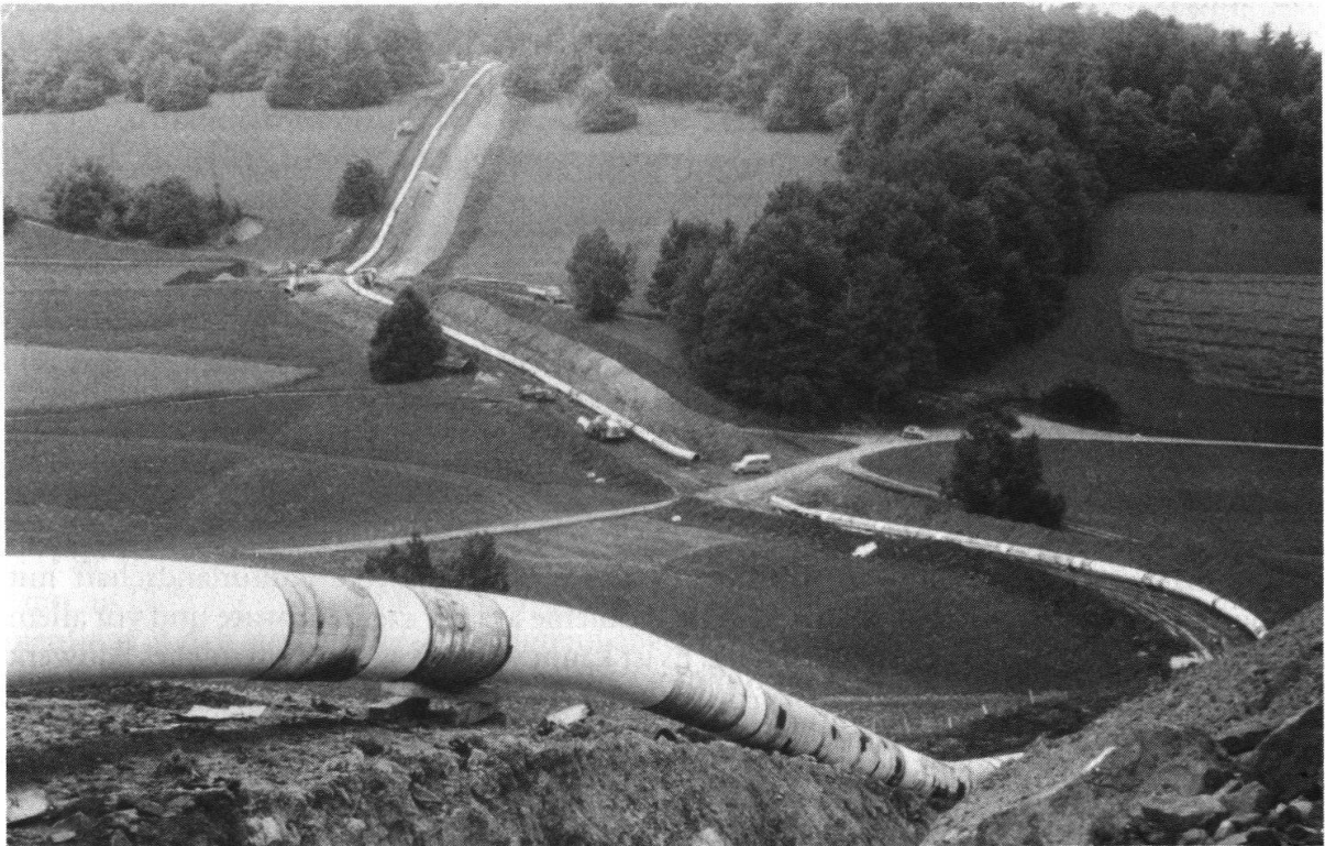
Fig. 1 Gasleitung bereit um verlegt zu werden. Schafmatt, Gemeinde Oltingen, BL. Koordinaten der Kreuzung Strasse/Pipeline. Landeskarte 1: 25 000, Blatt 1089 Aarau: 638.120/252.350. Aufnahme Richtung NW 24. Juli 1973.
