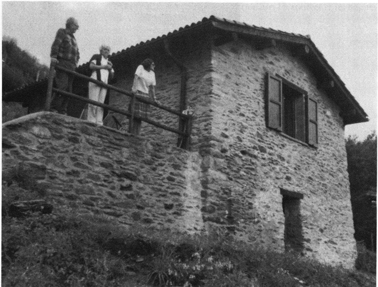
Fig. 8 et 9 Constructions rurales de montagne au Val Colla (Tessin) restaurées, avec pierres d'origine locale mises en évidence. La diversité des formes et des teintes des blocs, ainsi que la texture des murs à ras de pierres ou avec blocs en saillie, montrent l'ancienne technique paysanne et respectent le paysage humanisé par l'agriculture de montagne.
