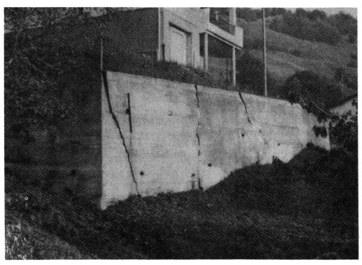
fig. 4 Le même terrain, à droite de la maison vers le haut, brutalement coupé par un ouvrage en béton, techniquement et géologiquement erroné et ruinant les site (Photo B. Campana).
