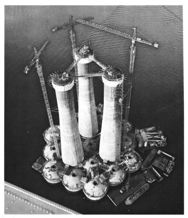
Fig. 20: Förderplatform für das Brent-Feld (Nordsee). Die heute im Bau befindliche Platform misst 225 m Höhe. An ihrem zukünftigen Standort, bei 145 m Wassertiefe, wird sie ab 1980 pro Tag 28000 t Erdöl fördern
