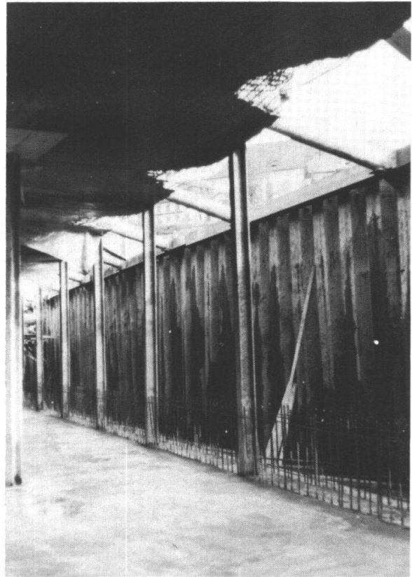
Abb. 14: Baugrubenabschluss, Verspriessung und Montage-Stützen. (Photo A. E. GONIN, Ingenieurbureau Dr. Staudacher & Siegenthaler AG, Bern).
