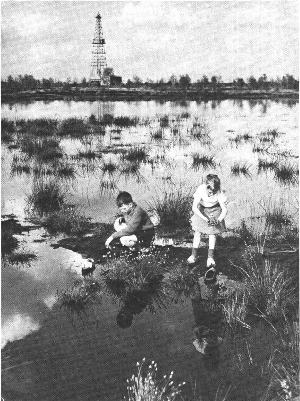
Fig. 2: Bohrung im Naturschutzgebiet im NE der Niederlande. Nach Abteufen wird der Bohrturm abgebaut und der allfällig entstandene Landschaftschaten durch Anbau wieder gutgemacht.
