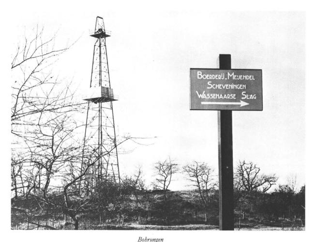
Fig. 1: Bohrung im Dünengebiet bei Wassenaar-Scheveningen, das zum Grundwasserschutzgebiet von Den Haag gehört. Durch fachmännische Verrohrung und Zementierung wird das Grundwasser gegen Verunreinigung geschützt. Nach Ausführung der Bohrung wird die Bohranlage abmontiert.
