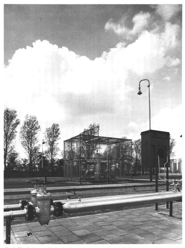
Fig. 5: Eine Bohrung auf Erdgas bei Slochteren (Groningen) wurde fündig. Absichern des Produktions kreuzes durch Eingitterung; saubere Installations- und Umgebungsarbeiten. Bei der Beurteilung des allfällig störenden Einflusses solcher Anlagen muss berücksichtigt werden, dass im günstigen Falle eine einzige Gasbohrung etwa viermal die Gesamtproduktionskapazität des Gaswerkes Schlieren (mit all seinen Anlagen) aufweisen kann!
