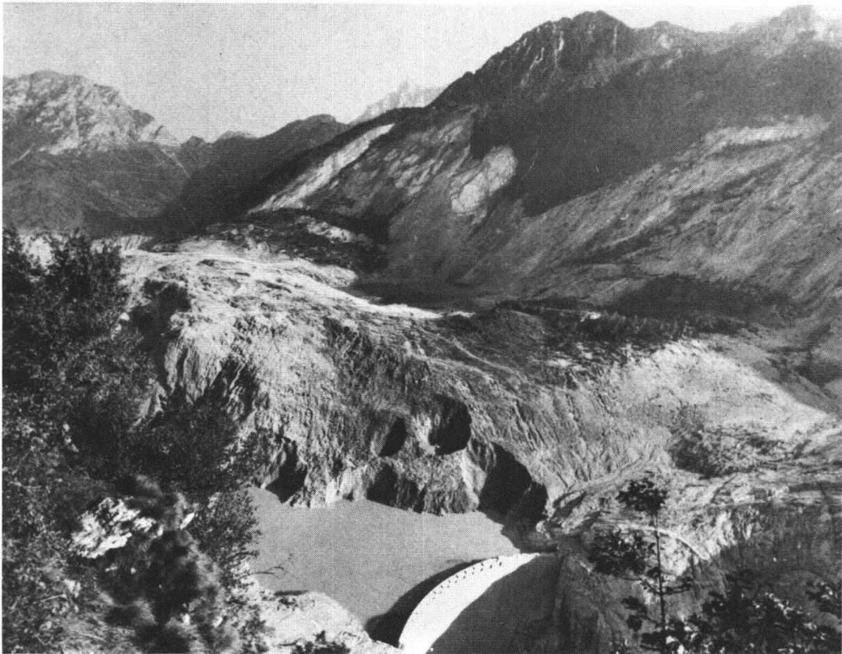
Fig. 8: Mitte: Sturzmasse, teilweise mit Quartärüberdeckung (Versickerungstrichter). Darüber: Gleitfläche, hell. Mitte unten: Staumauer, mit Restsee.
