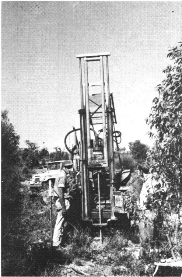
Fig. 15 et fig. 16: Gisements de bauxite de Chittering: détails des opérations de sondage sur la croûte bauxitique («hardcap»).
