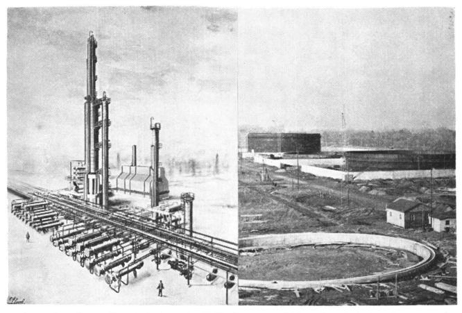
A gauche: Perspective de la tour de distillation atmosphérique (topping) dont le montage débutera au printemps 1961. — A droite: Le parc de réservoirs est en construction; le premier tank de 35'000 m³ (au fond) est achevé (Photo: Pot, Monthey)
