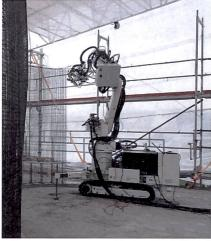
Abb. 8. Konstruktionsroboter: HEAP und Roboter für den Aufbau gewölbter Armierungen.
