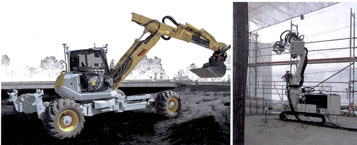
Abb. 8. Konstruktionsroboter: HEAP und Roboter für den Aufbau gewölbter Armierungen.
