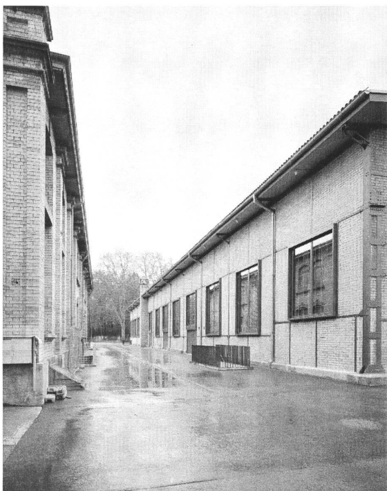
Abb. 1: Die alte Weichenbaufabrik von Roll.
