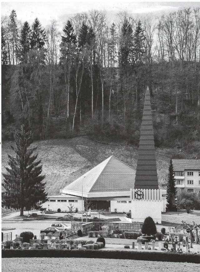
Katholische Kirche in Wünnewil, Kanton Freiburg, Foto: Stephan Coray
