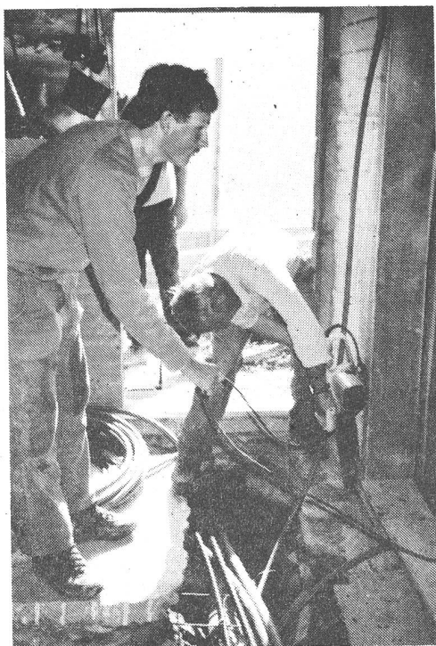
August 1988. Michel Briemann und Viktor Buser, beide als Elektromonteure bei Rohreinlegungen für Elektroinstallationen, bevor der Boden zubetoniert wurde.
