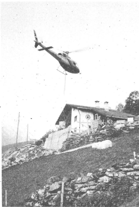
Freitag, 22. September 1988, 8.30 Uhr. Betonieren der Stützmauer per Helikopter. Siehe: Sonnenschein durch das Martinloch Richtung "Tristel"!
