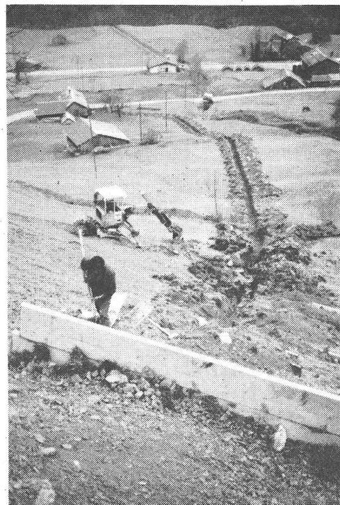
Oktober 1988. Einlage von Aussenkanalisation und Elektro-rohren durch die Bauunternehmung, ca. 400 m Länge bis zum Dörflein Steinibach ob Elm.
