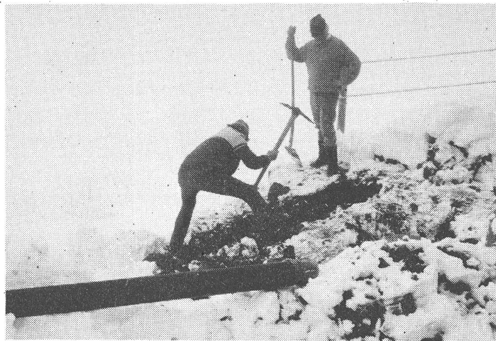
Ende April 1989. Ausgrabung für die Sicker- röhre des geschenkten Trinkwasserbrunnens. Harte Arbeit für frondienstleistende Gehör- lose trotz des starken Schneetreibens, etwa 25 cm Schneedecke.
