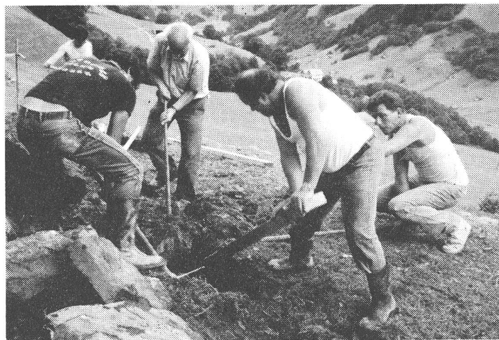
Mai 1988. Grosse schwere Steine wegtragen zur Deponie für die künftige Stützmauer der Terrasse (Gartensitzplatz).
