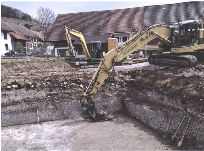
Abb. 4 Elfingen-Dorfstrasse, April 2021. In der Baugrubenwand sind die Reste der mittelalterlichen Hofplanie als deutlich erkennbare Kalksteinplanie und Kulturschicht erkennbar.
