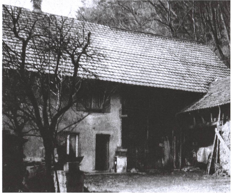
Abb. 5 Maries Elternhaus in Schwörstadt in den 1970er Jahren. Das Haus ist inzwischen abgebrochen worden.
