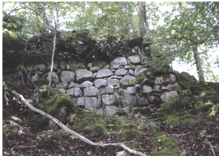
Abb. 4 Tiefenstein. Mauer an der südwestlichen Längsseite der Kernburg (2019).
