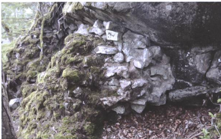
Abb. 8 Iburg. Mit Mauerwerk abgestützter Fels (Westseite des nördlichsten Felsens, 2019).
