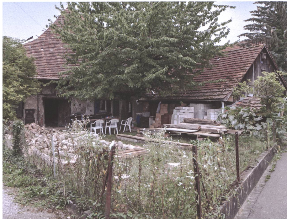
Abb. 4 Das Hochstudhaus an der Unterdorf- strasse 19 in Wallbach zu Beginn der Umbauarbeiten. Das Vollwalmdach verrät die Hoch- studkonstruktion.
