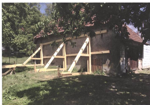
Abb. 9 Temporäre Bausicherungen aus Holz stabilisieren das Hotzenhaus während der Umbaumaassnahmen.
