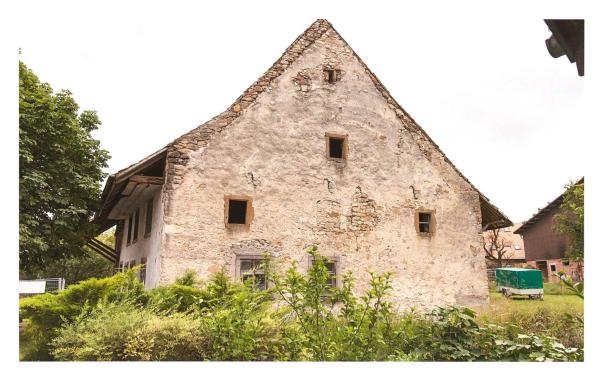
Abb.7 Giebelwand M1, die wegen statischer Probleme an den Dachstuhl von 1808 d angepasst werden musste.
