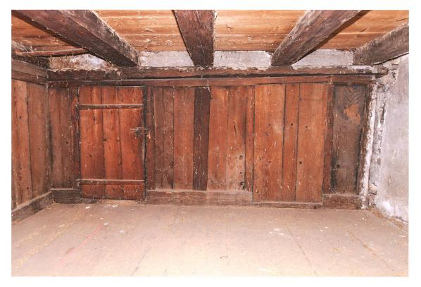
Abb.8 Längswand in Kammer R 1.3. Rechts ist sie aus dem Mauerwerk ausgefahren.
