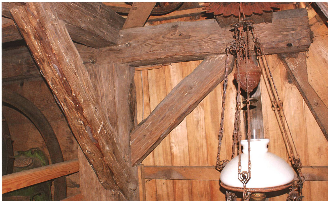
Abb. 4 Dachüberstand an der Rücktraufe im Zuge der fünften Querachse. Am Kopfband findet sich, der Querachse entsprechend, ein Abbundzeichen mit fünf kleinen Dreieckskerben.
