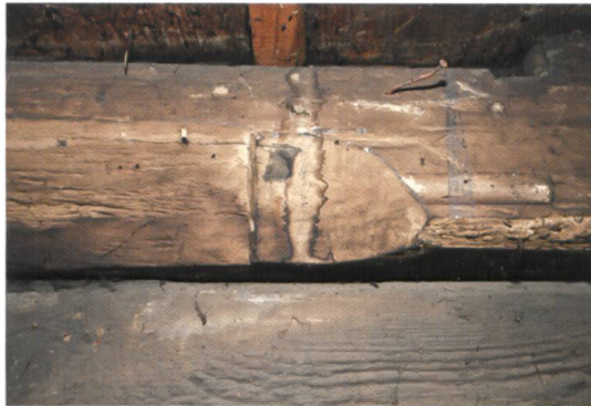
Abb. 4 Beispiel einer breiten, nachgotischen Fasse in der Schlafkammer des 1548 errichteten Hochstudhauses am Blumenrain 2/4 in Othmarsingen. (C. Gut)
