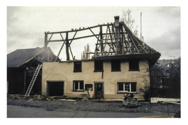
Abb. 2 Die freigelegte Hochstudkonstruktion des Hauses Bodengasse 54 in Wölflinswil beim Abbruch im Winter 1994/95. (D. Wälchli)
