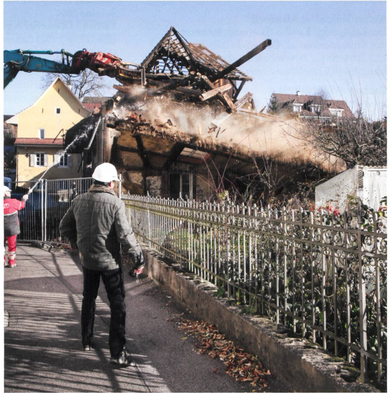
Abb. 15 Die südwestliche Fachwerkwand stürzt ein (am Abbruchtag im Dezember 2013).
