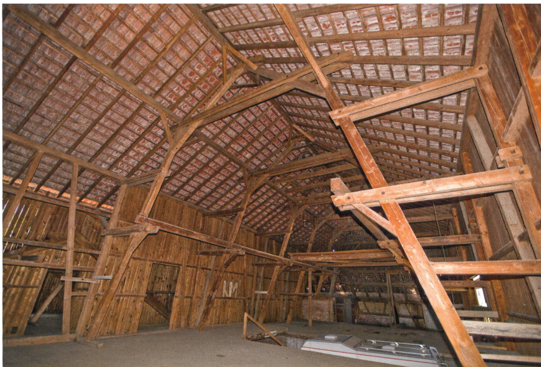
Abb. 12 Die moderne Scheune (Obergeschoss). Im Hintergrund ist der geöffnete Ökonome- trakt des Fachwerk- hauses zu sehen (Ansicht von Osten).
