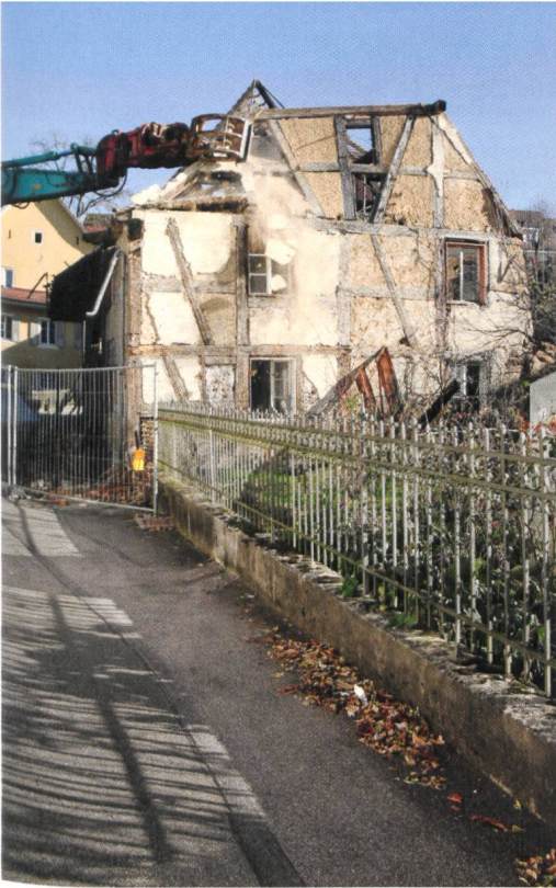
Abb. 14 Der Bagger knabbert am Fachwerkgiebel der Südwestfassade (am Abbruchtag im Dezember 2013).
