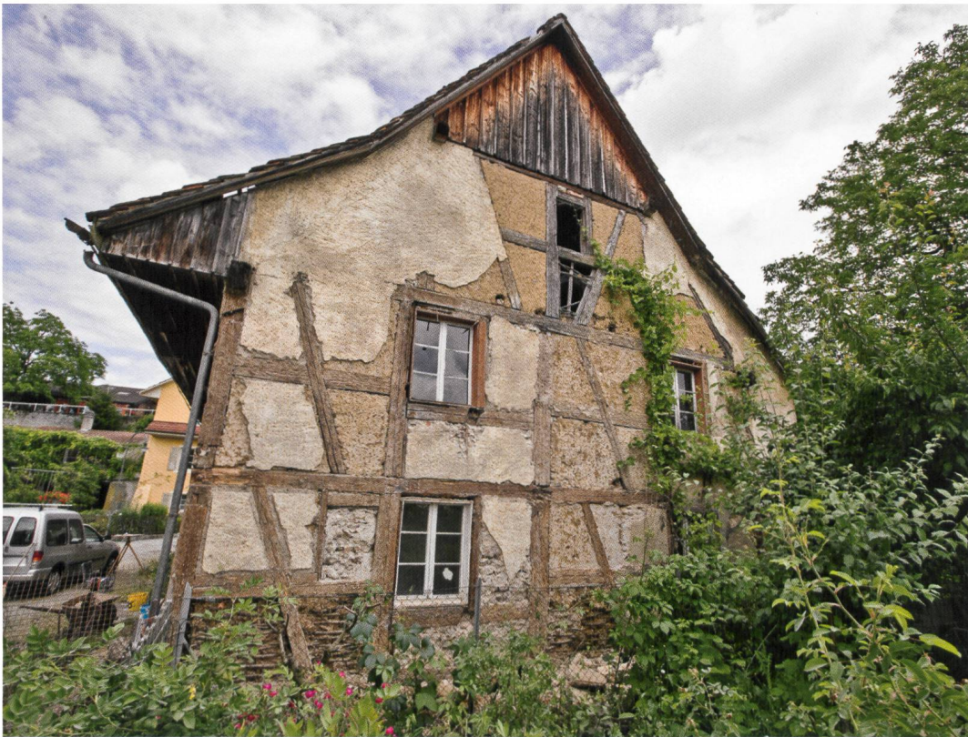
Abb. 13 Die intakte Südwest- fassade, nachdem der Verputz grösstenteils abgeschlagen worden ist.
