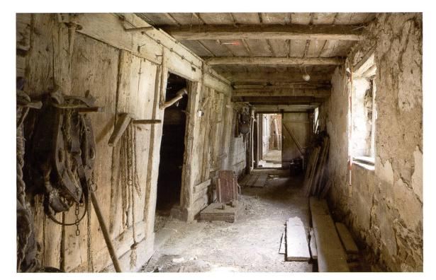
Südlicher Laubengang mit Blick in Richtung Wohnteil. Unterschiedliche Setzungen von bergund talseitigem Baugrund haben bereits kurz nach seiner Erbauung zu starken Verformungen des ursprünglichen Holzbaus von 1748 geführt.
