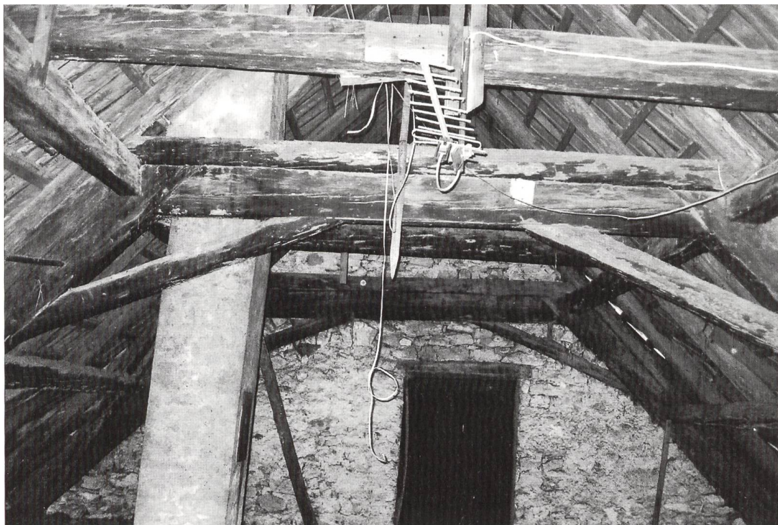
Abb. 15 Doppelhaus Frick, Kirchmattweg Nr. 5, Detail des liegenden Dachstuhls von 1808 mit Blick gegen die Brandmauer zur Tenne hin.
