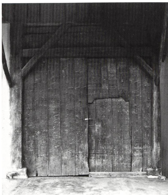
Abb. 14 Doppelhaus Frick, Kirchmattweg Nr. 5. Scheunentorkonstruk- tion mit doppeltem Jochbalken. Doppel- flügeltor, rot-schwarz gefasste Einkerbungen über dem Mannstor. Die eichenen Wand- ständer von 1610 stehen in Schwell- schlössern.
