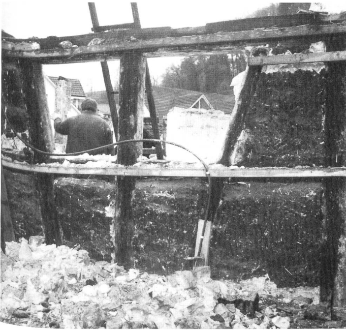
Abb. 12 Rauchschwarze Fachwerkwand im Obergeschoss sowie eines der 1781 zu- gemauerten Fenster im westlichen Giebel.
