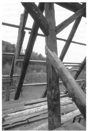
Abb. 6 Ankerbalken mit Schwalbenschwanzverbindung auf dem Mittelständer der Fachwerkkonstruktion.
