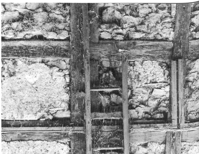
Abb. 6 Ankerbalken mit Schwalbenschwanzverbindung auf dem Mittelständer der Fachwerkkonstruktion.
