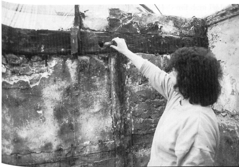
Abb. 17 Rita Aeschbacher- Deiss zieht einen Zap- fen aus der Verbohrung in der Fachwerkwand zum Hausgang.
