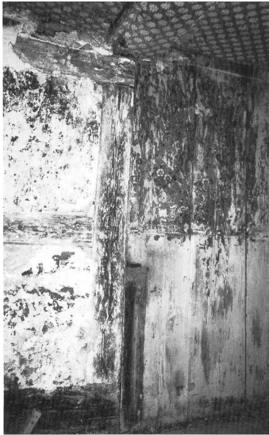
Abb. 10 Die Binnenwände der Stube bestanden aus Fachwerk- und Bretterwänden. Am Ende des 19. Jahrhunderts bezog man Wände und Balkendecke mit Tapeten.
