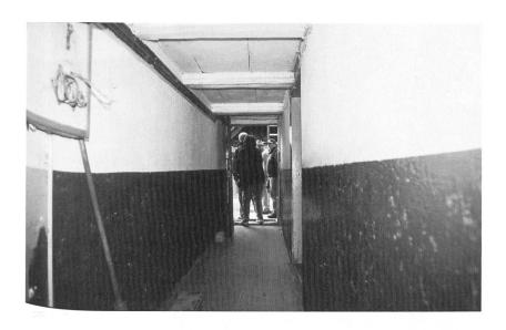
Abb. 8 Die gefasten Deckenbalken mit Schiebboden im Hausgang.
