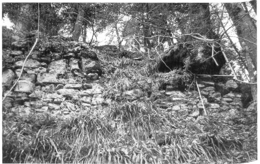
Abb. 3 Nordende der Terrassenmauer der «Vorburg». Deutlich ist die Gefährdung durch die grosse, schräg stehende Linde zu erkennen.
