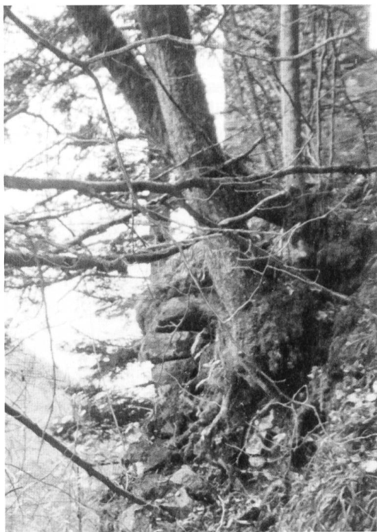
Abb. 4 «Vorburg», südliche Stützmauer, im Hinter- grund der Torpfeiler der Oberburg. Die extreme Topografie wird auf diesem Bild ebenso deutlich wie die Ge- fährdung der Trocken- mauer durch den Baumbewuchs.
