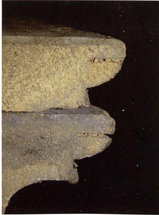
Abb. 44 Diese oberen Friesteile sind an den Eckstößen horizontal eingesägt. Nach dem Aufnageln des Frieses leimte der Schreiner hier eine kleine Feder ein. So konnten sich die Ecken nicht gegeneinander verziehen.
