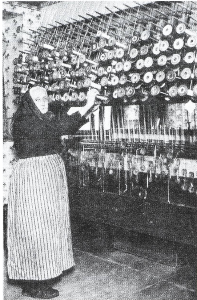
Abb. 3: Rückseite eines Seidenbandwebstuhls in Bergalingen DE mit aufgesteckten Kettfadenspulen. (Bild: Hochrhein und Hotzenwald. Badische Heimat 9 [1932])
